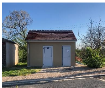
Après les travaux
