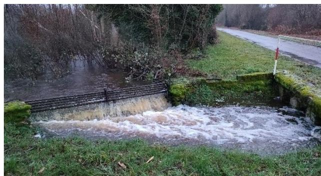
Plusieurs exemples de rupture de digues existent dans des conditions similaires. Afin de limiter au maximum ce risque, la décision a été prise d'interdire la circulation sur la voie communale supportée par la digue aux véhicules de plus de 3,5 tonnes. Les riverains et les principaux utilisateurs de ce parcours ont été avisés. Des panneaux vont être installés très rapidement.
