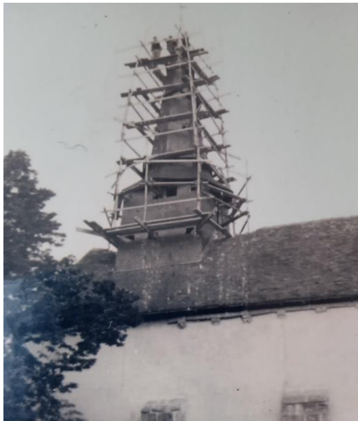
Travaux sur le clocher en 1965
